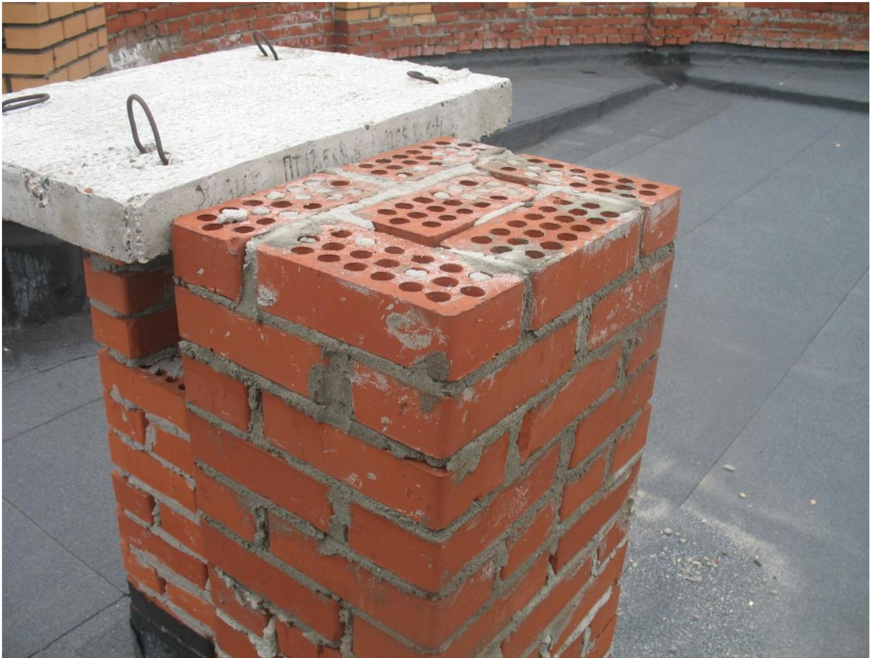
Фото 5. Частично отсутствует покрытие вентиляционной шахты.
