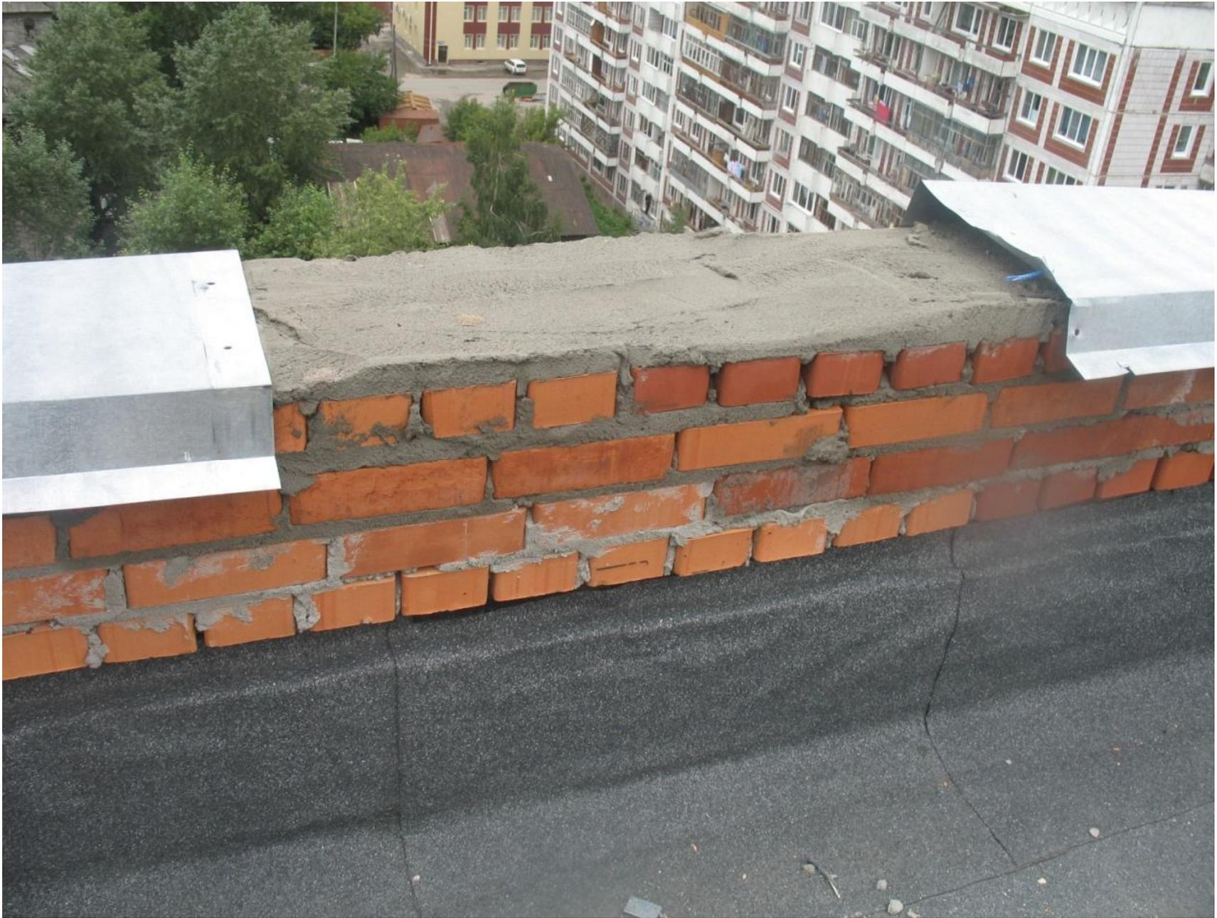
Фото 4. Отсутствует часть покрытия парапета.
