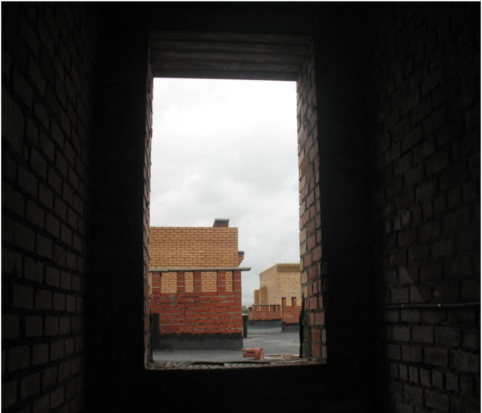
Фото 7. Отсутствуют двери выхода на чердак, крышу и в машинные помещения лифтов.
