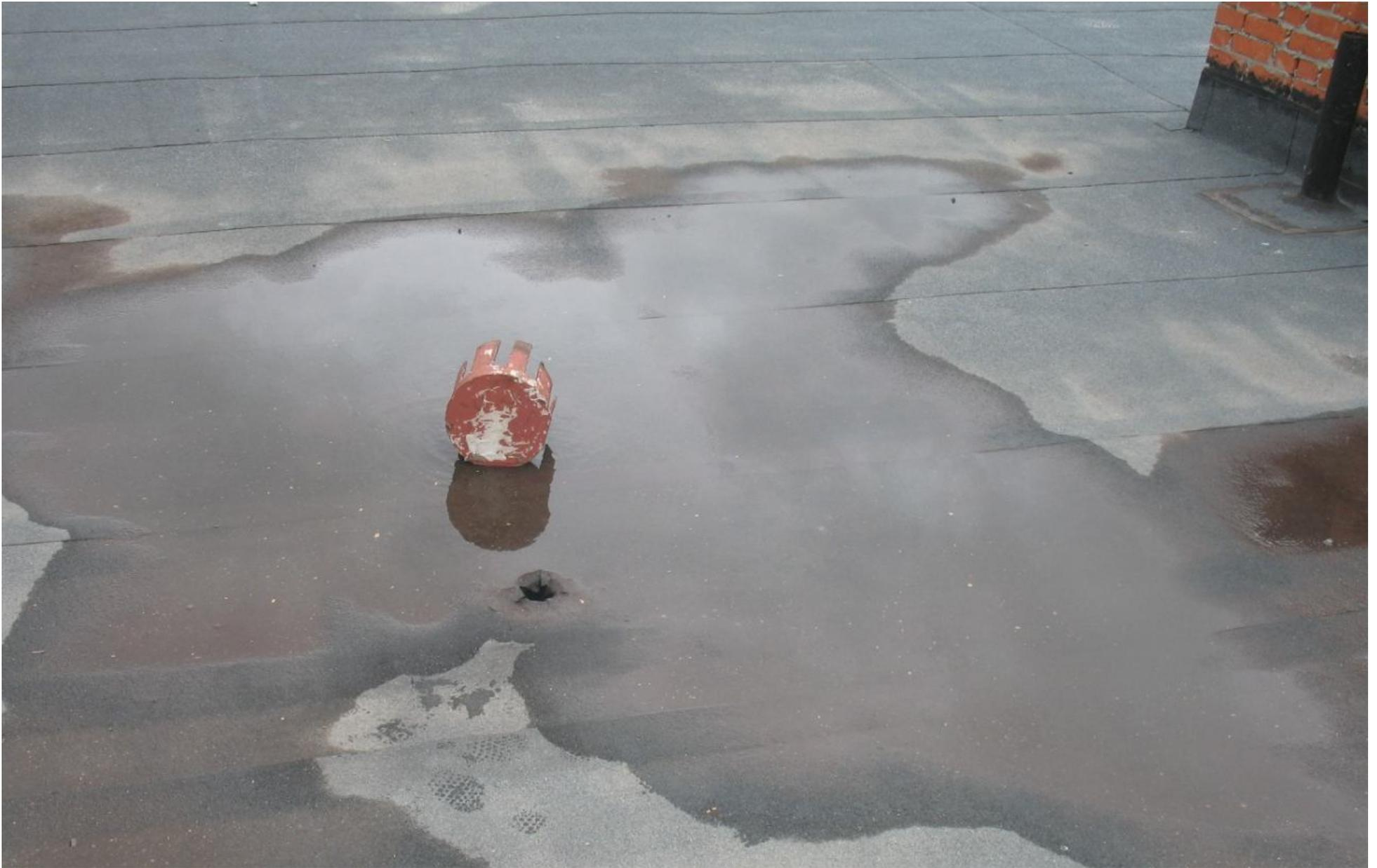
Фото 6. Требуется ремонт покрытия кровли и установка воронок.
