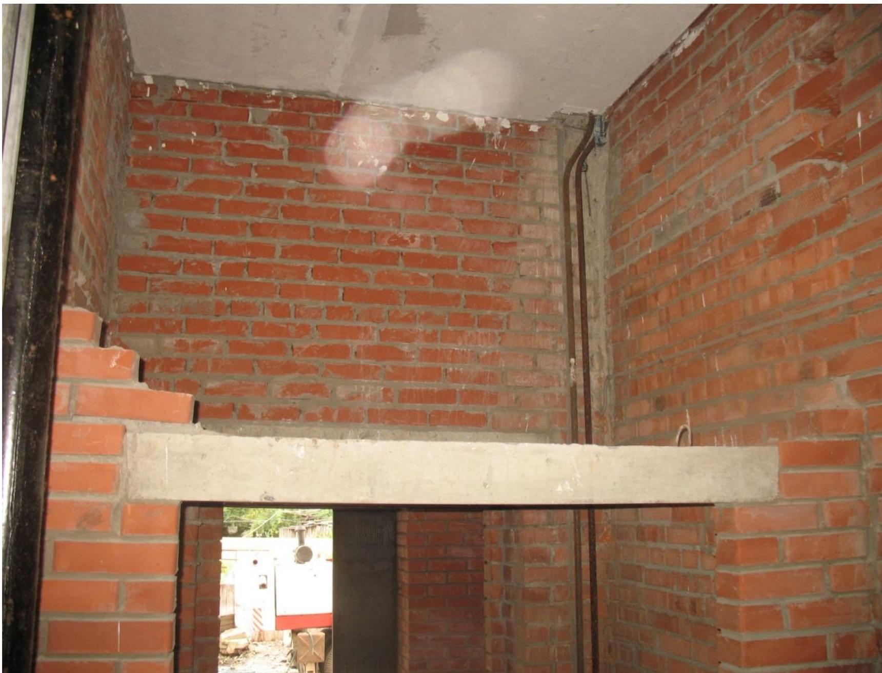
Фото 2. Отсутствует часть перегородки в тамбуре 2 подъезда.
